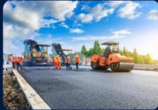
ก่อสร้าง บูรณะ และแก้ไขปัญห งานก่อสร้าง โดยวิธีดำเนินการเอง
